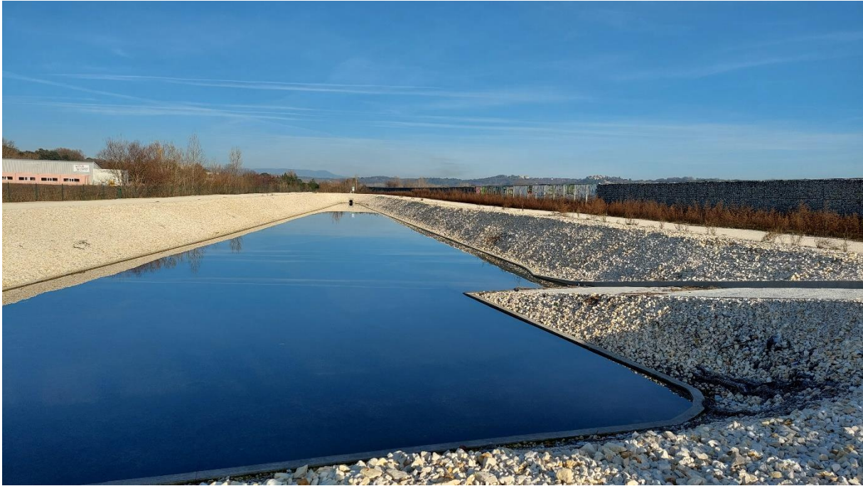
Figure 2 : Bassin routier sur l'axe RN106 Nîmes-Alès
